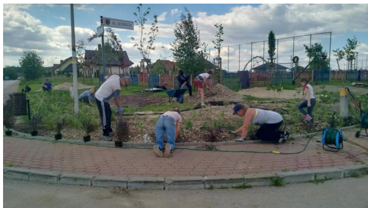
Fotografia 5. Prace w trakcie realizacji ogrodu deszczowego
