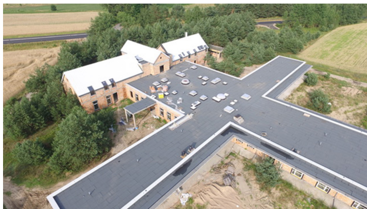
Fotografia 3. Budowane hospicjum stacjonarne
