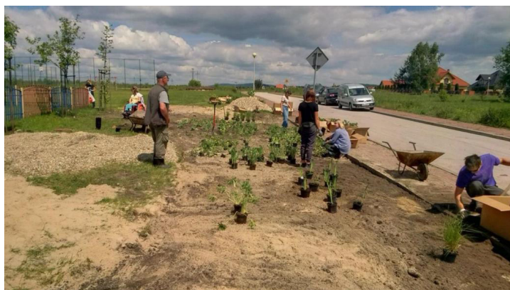
Fotografia 6. Prace w trakcie realizacji ogrodu deszczowego
